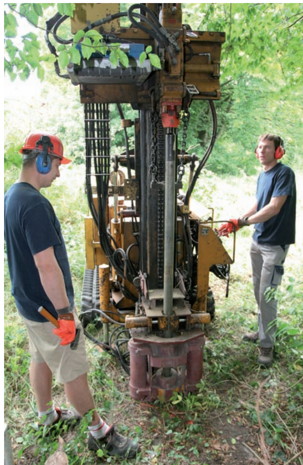
Forage sur un site pollué.
