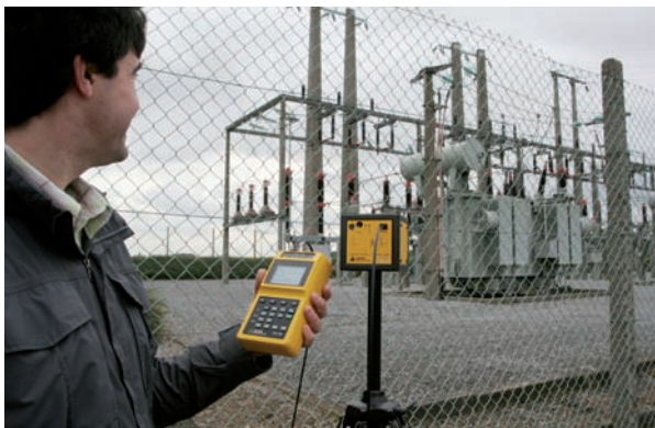
Mesure du champ électromagnétique à proximité d'un poste de transformation électrique.
