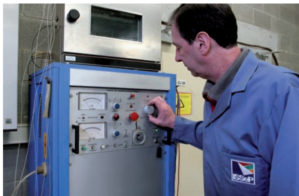
Essai diélectrique haute tension
