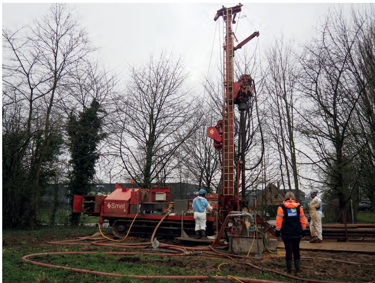
Carottage de sol sur site à réaffecter
