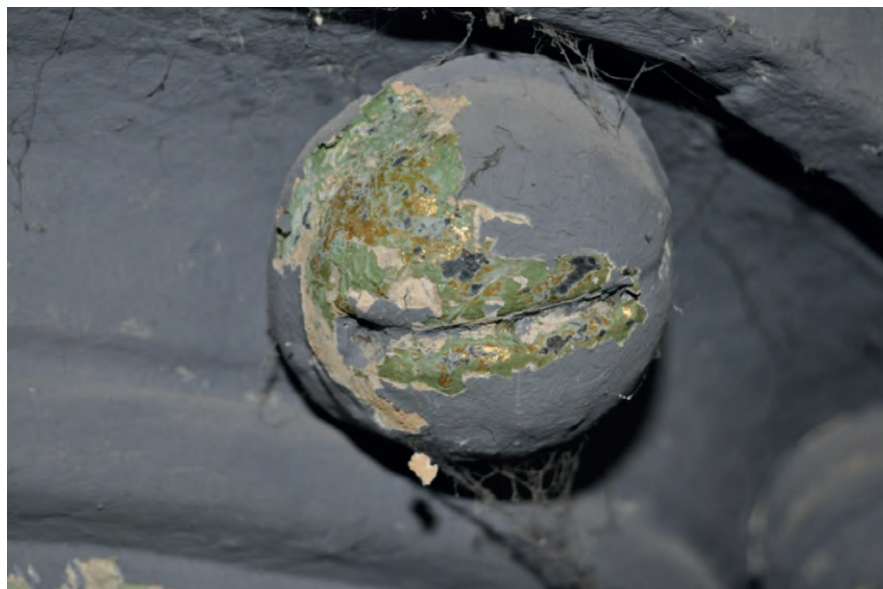
Mise à jour d'une dorure à la feuille d'or sur des éléments des colonnes en fonte intérieures, Grand'Poste de Liège
