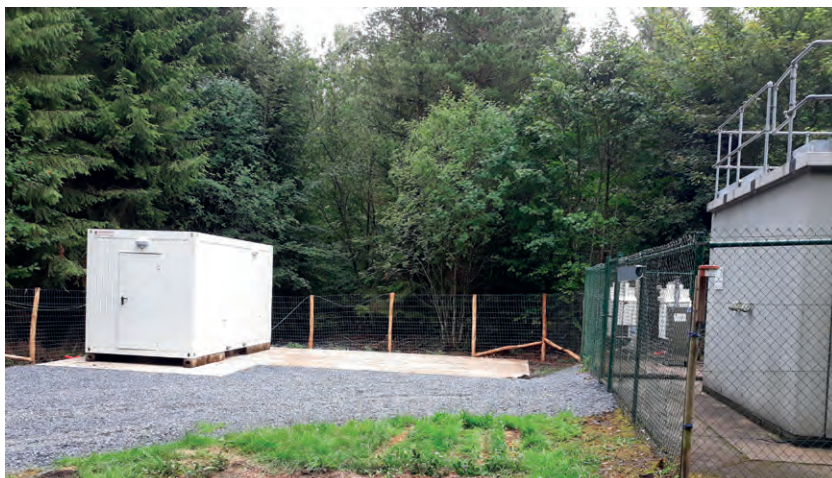
La station de Vielsalm après aménagement et installation d'un nouveau container
