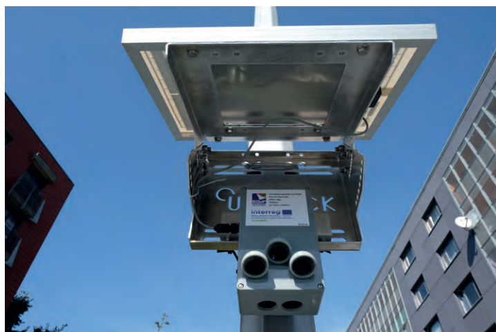
Installation d'une station de mesure de la qualité de l'air - Liège.
