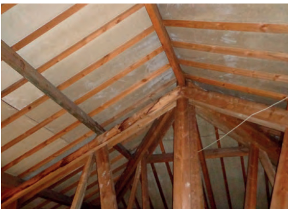
Sous-toiture en « menuiserie »
