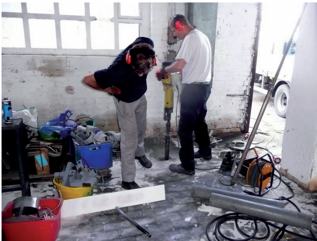
Etude d'un site potentiellement pollué - forages en vue de prélever des échantillons de sol.
