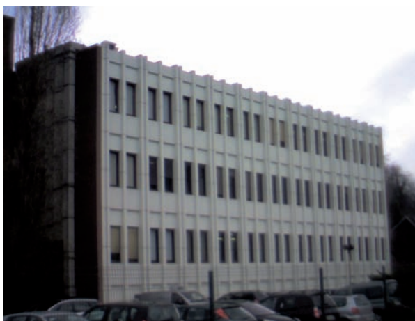
ISSeP – Bâtiment Labo (photo traditionnelle).
