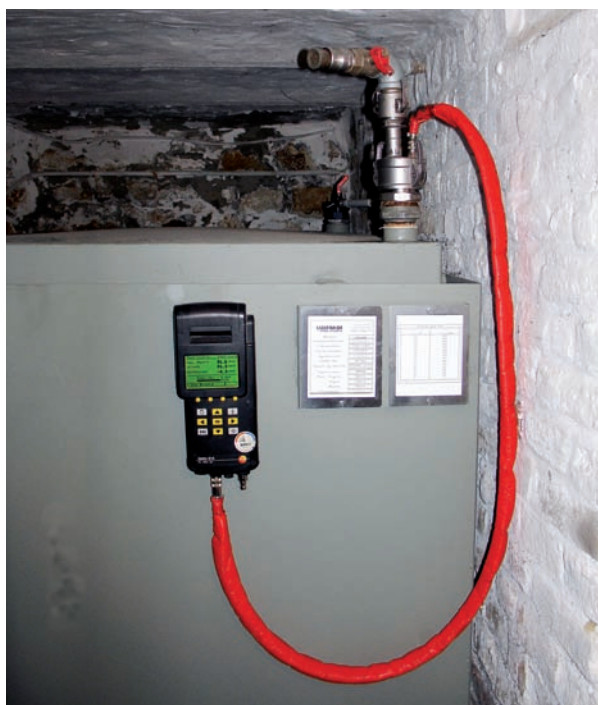
Test d'étanchéité d'un réservoir à mazout.
