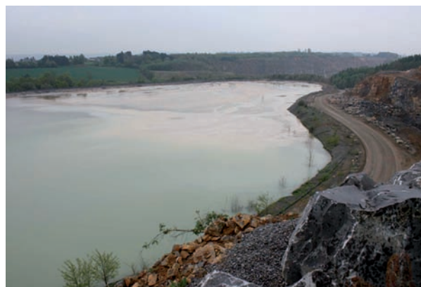
Bassin de décantation. Exemple d'installation de gestion des déchets qui devra être couvert par un permis et faire l'objet d'un classement suivant l'AGW de 27 mai 2009.
