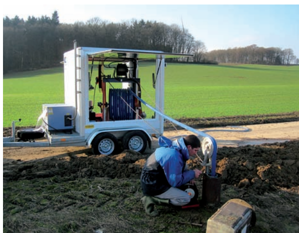
Conteneur de pompage 3 pouces pour puits profonds (jusqu'à 80 mètres).
