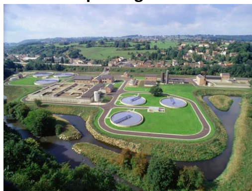
Station d'épuration en Région Wallonne Source : site WalEurope
