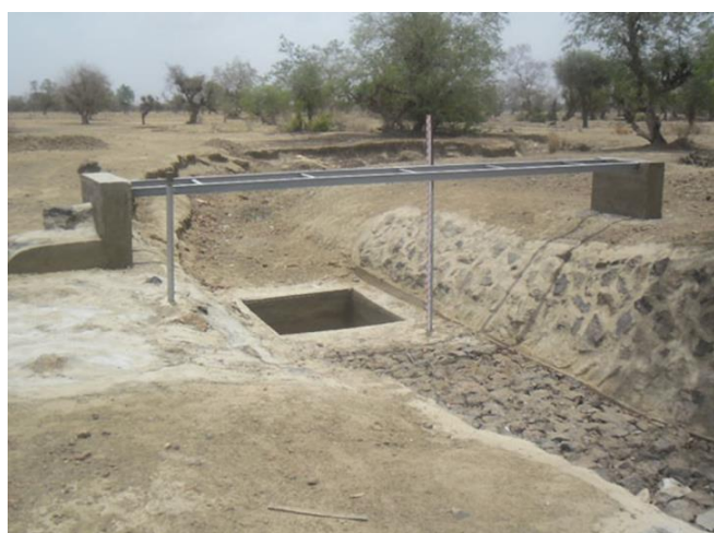
Dispositif de mesures des débits et de la charge de fond.
