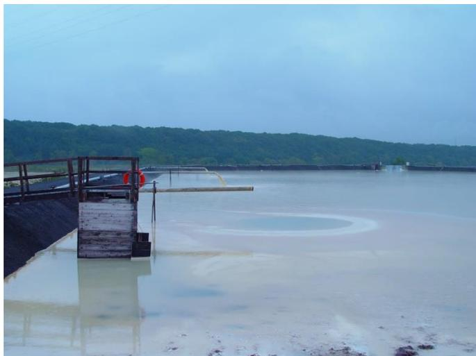
*(A1-5) Bassin de décantation d'effluents d'un C.E.T. de classe 5*
