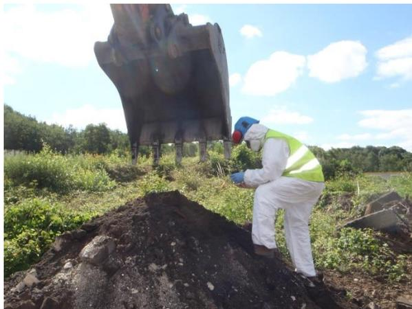
*(A1-2) Analyse visuelle des terres excavées lors d'une tranchée à la recherche de matériaux contenant de l'amiante*
