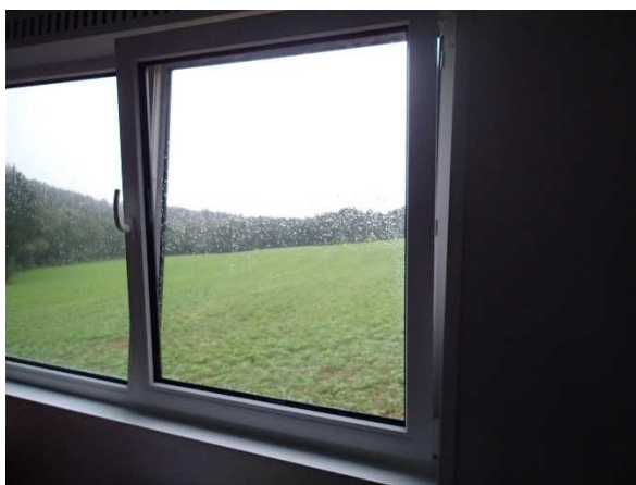
Figure 27. Fenêtre d'un bloc préfabriqué d'une école en bordure de champ cultivé
