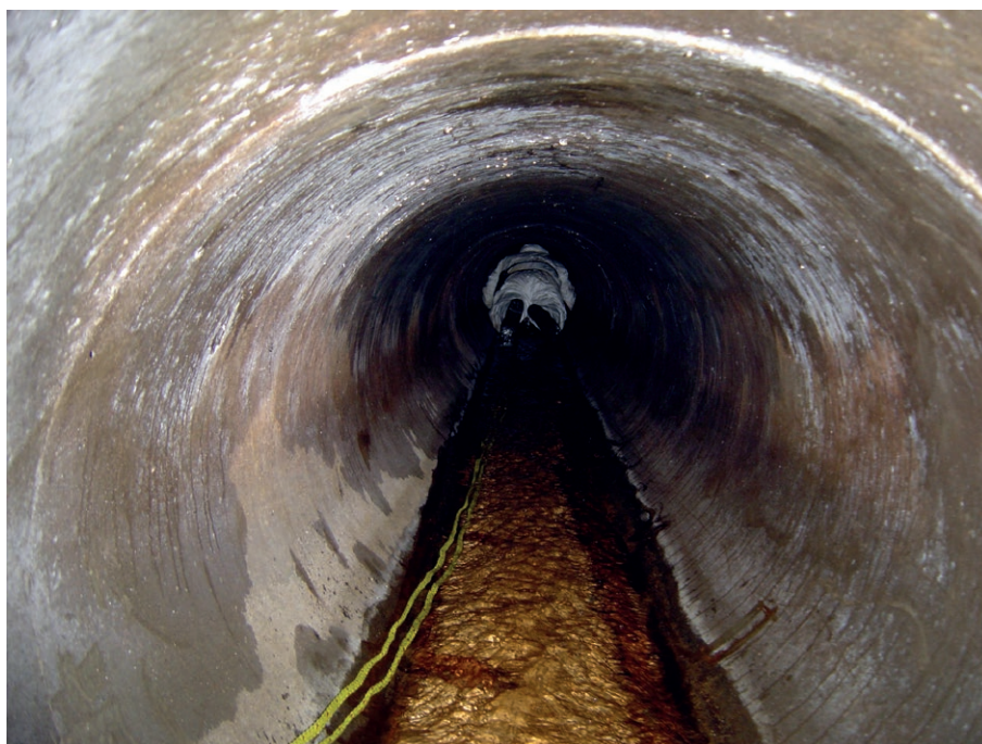
Auscultation d'une galerie d'exhaure. Contrôle des transferts hydrauliques dans les anciens massifs miniers exploités
