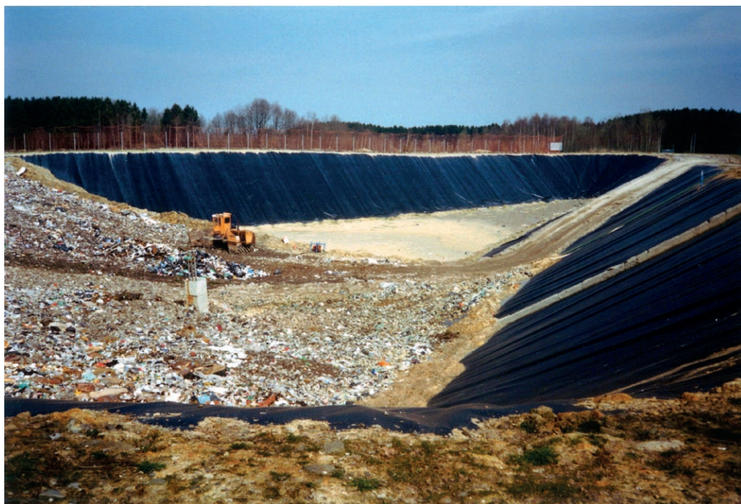
Aménagement d'un casier avant exploitation. C.E.T. de Morialmé en 1995
